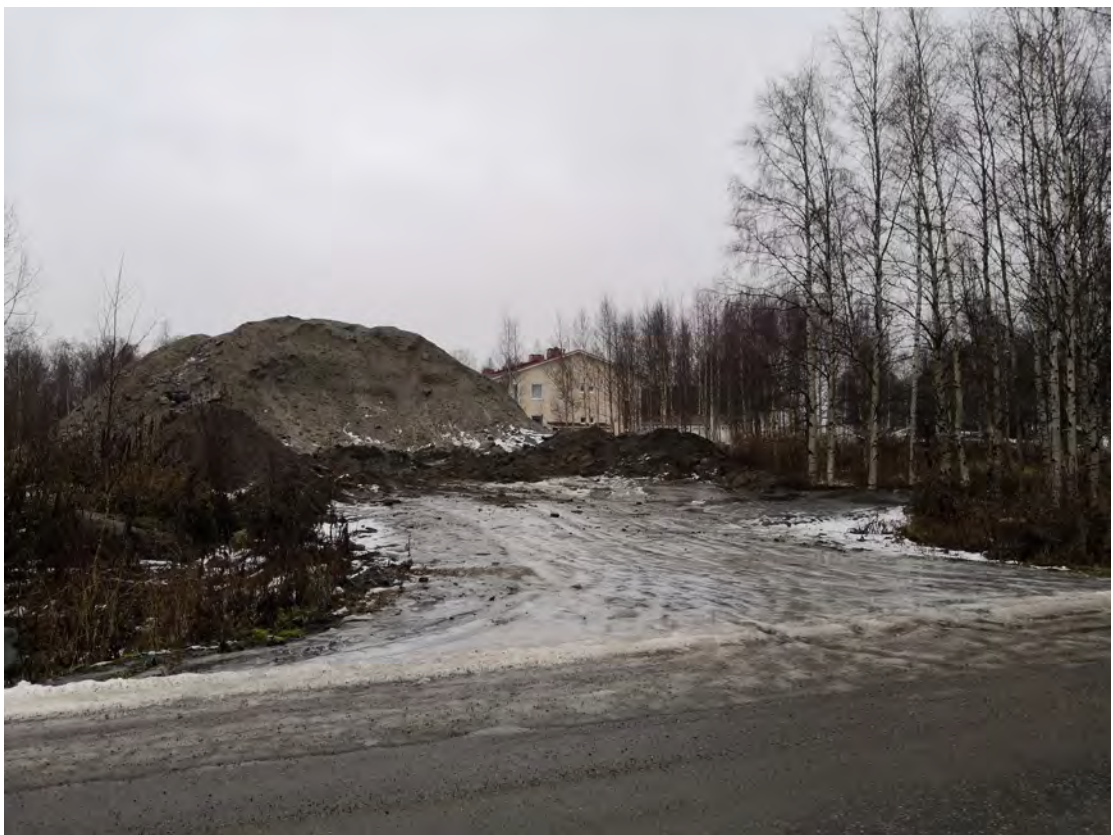
KUVA 5 Kuva suunnittelualueesta. Alueelle on väliaikaisesti varastoitu Näränperän tulvavallin korotukseen tarkoitettuja maamassoja.
