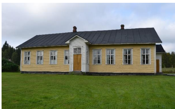
Tervolan koulumuseorakennuksen katto kunnostettiin valtionavustuksella.
