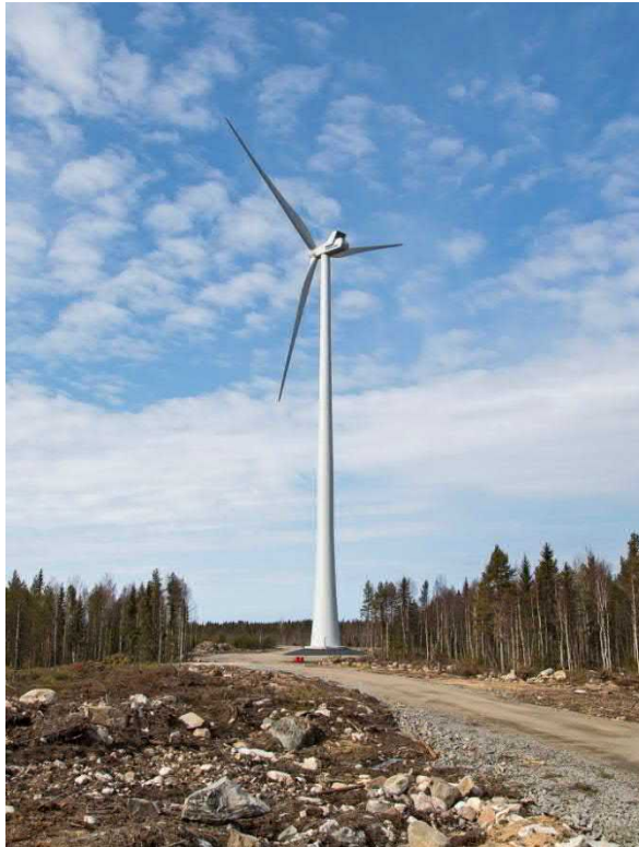
Kuva 2.9. Vasemmalla on esimerkki teräslieriötornista ja oikealla hybriditornista. (Kuvat: Leila Väyrynen ja Ville Suorsa, FCG)
