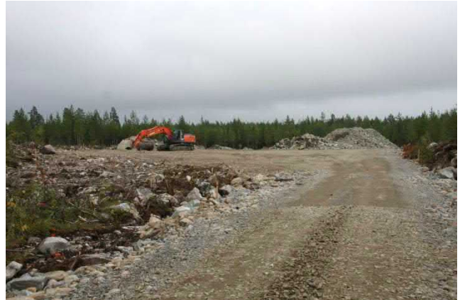
Kuvapari 2.17. Tuulivoimapuiston rakentaminen alkaa huoltoteiden ja pystytysalueiden rakentamisella (kuvat: Ville Suorsa, FCG).
