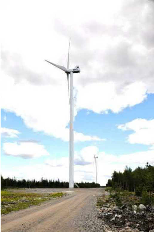
Kuva 2.9. Vasemmalla on esimerkki teräslieriötornista ja oikealla hybriditornista. (Kuvat: Leila Väyrynen ja Ville Suorsa, FCG)
