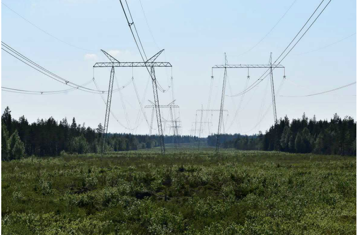
Kuva 5.28. Hankkeen sähkönsiirtoreittiä on tutkittu levennettävän 33 metriä voimajohtokäytävän osalta. Reitin itäosassa johtokäytävässä on rinnakkain kaksi 400 kV voimajohtoa.
