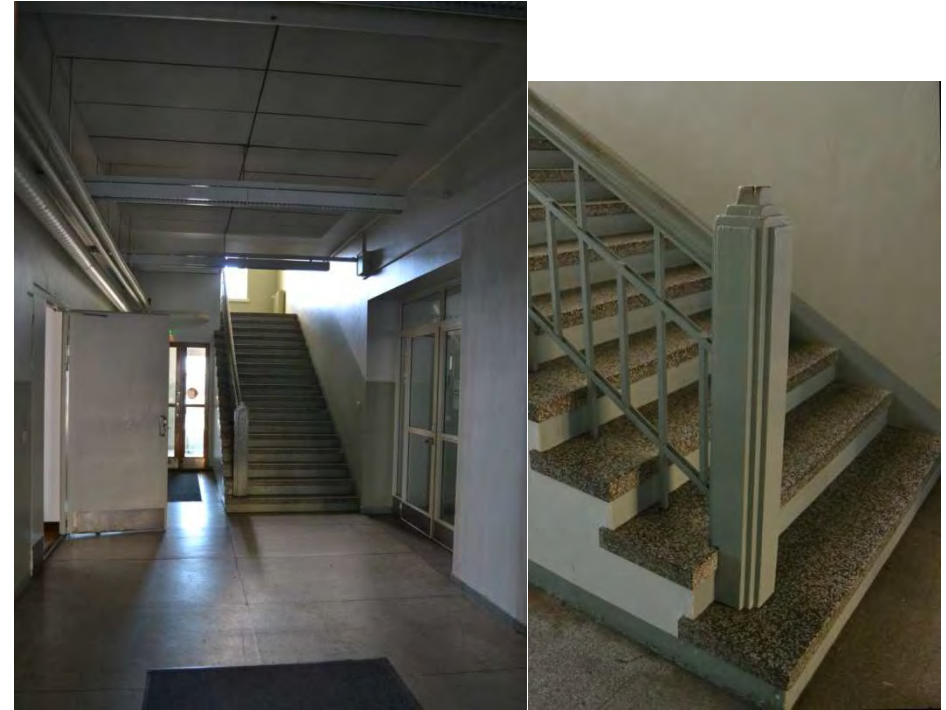
Kuvat 90–91: Vanhan puolen pääporras ja kaiteen detalji, 2018 (TLMM/Teija Ylimartimo)
