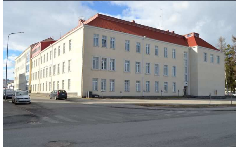
Kuvat 86–87: Koulurakennus Lukiokadulta, idästä ja etelästä, 2018 (TLMM/Teija Ylimartimo)
