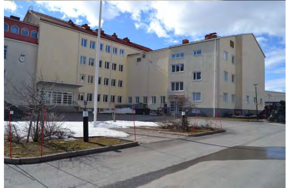
Kuvat 83-84: Sisäpiha pohjoisesta ja idästä 2018 (TLMM/TY)
