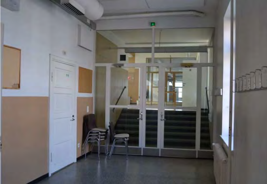
Kuvat 97-98: Vanhan puolen 3. krs käytävää ja palo-ovet pääportaikkoon (TLMM/TY)
