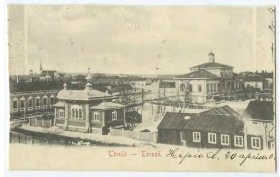
Kuva 21: Ortodoksikirkko ja raatihuone, oikealla korotettu Patalan talo (TLMM)
