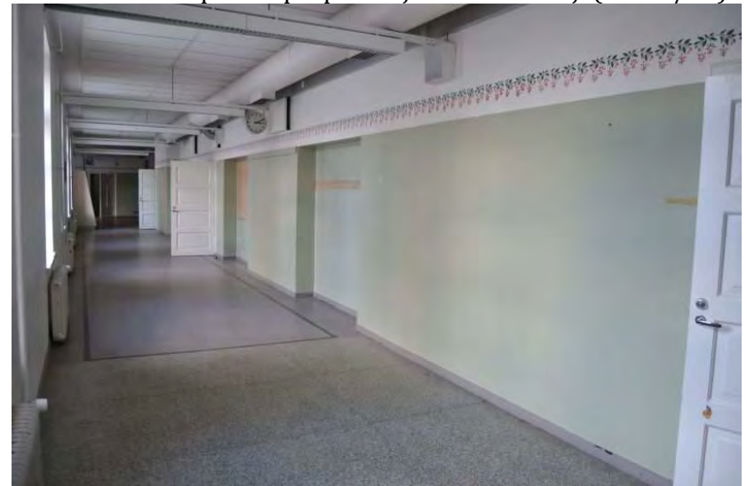
Kuva 92: Vanhan puolen käytävää 1.krs 2018 (TLMM/TY)
