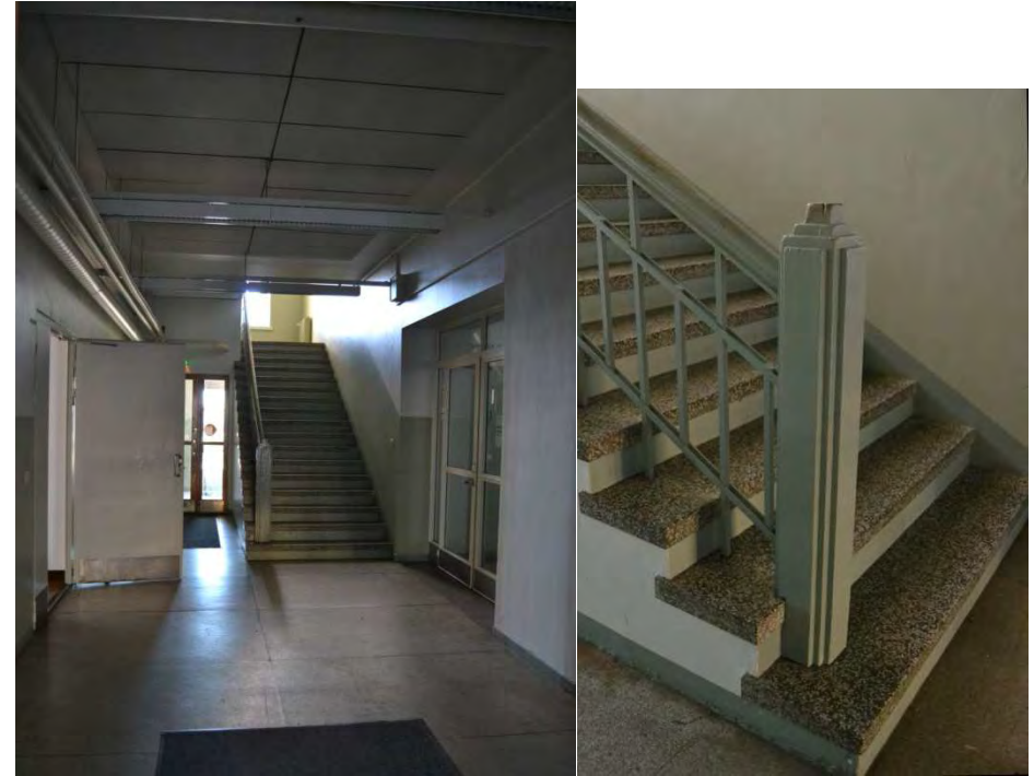
Kuvat 90–91: Vanhan puolen pääporras ja kaiteen detajli (TLMM/TY)
