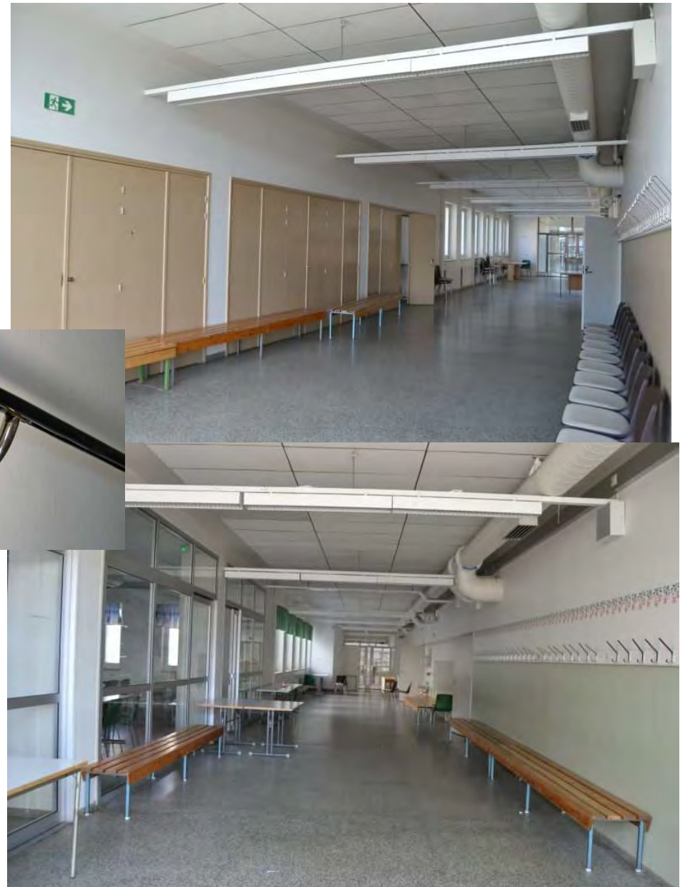
Kuvat 110-111: Uuden puolen 3. ja 1. krs käytävä 2018 (TLMM/TY)
