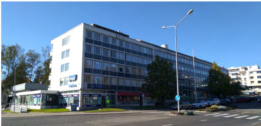
Kuva 2. Laivurinkadun varrella sijaitseva asuin- ja liikekerrostalo.
